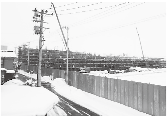
第一中学校区小中一体校建設現場
