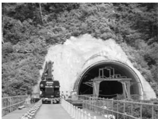
国道289号八十里越工事現場
