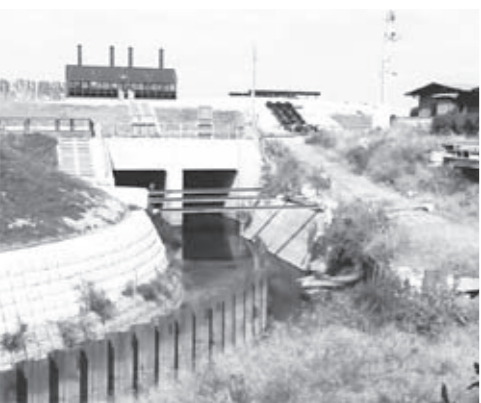
貝喰川排水樋門
