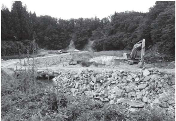
豪雨災害復旧現場(鹿熊川)
