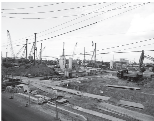
小中一体校建設工事現場
