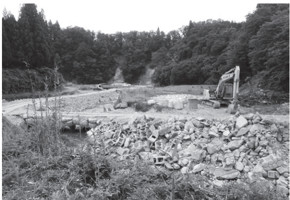
豪雨災害復旧現場(鹿熊川)
