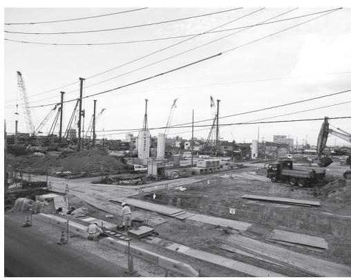
小中一校建設工事現場
