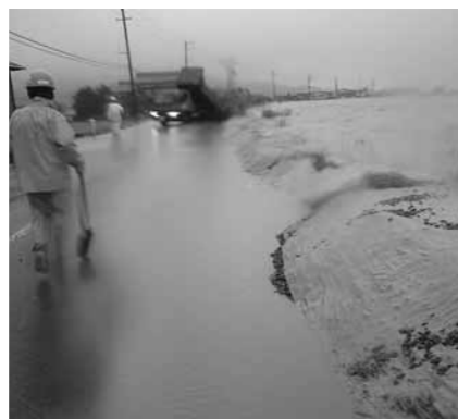
砂利でかさ上げをした五十嵐川左岸（島潟地内）
