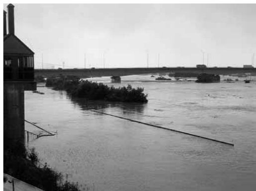
7・29豪雨災害時の信濃川と貝喰川樋門
