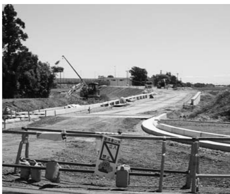
工事が進む栄スマートインターチェンジ
