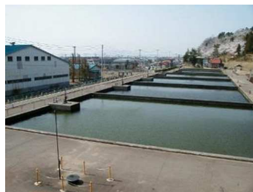
大崎浄水場 緩速ろ過池
