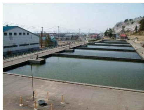
大崎浄水場 緩速ろ過池
