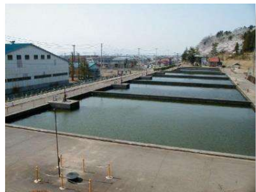
大崎浄水場 緩速ろ過池
