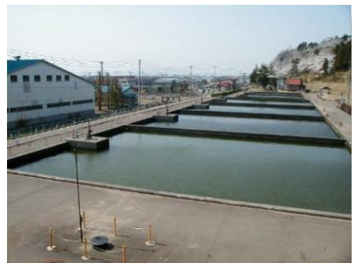
大崎浄水場 緩速ろ過池
