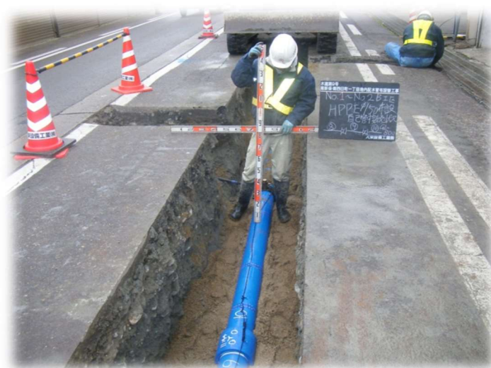
耐震管への布設替
