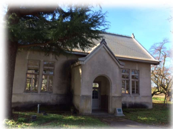
大崎浄水場第一取水場取水ポンプ室
