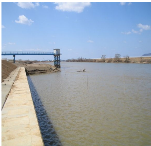
大河 信濃川(尾崎浄水場・取水塔)
