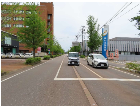
写真 3・4・10 新保裏館線 (三条市役所付近)
