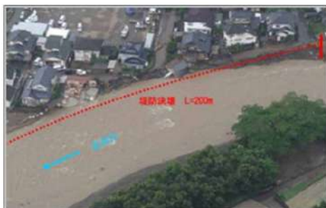
侵食により家屋が流失した状況
