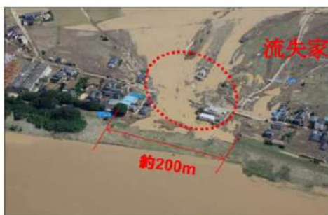
堤防決壊により家屋が流出した状況
