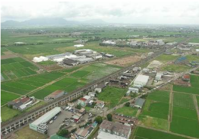
写真・国道8号沿線の産業拠点
