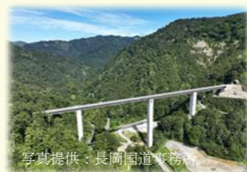
写真・国道289号八十里越区間
