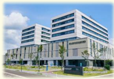
写真・済生会新潟県中央基幹病院
