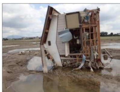
堤防決壊による家屋の倒壊
