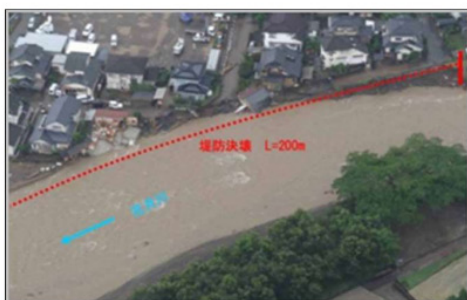
侵食により家屋が流失した状況
