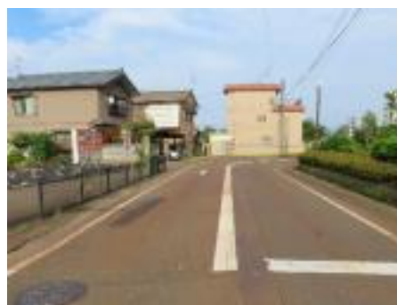
写真 7・6・6 側道3号線 (北三条駅付近)
