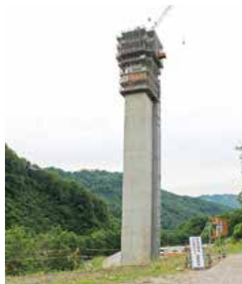
工事中 平成30年5月
