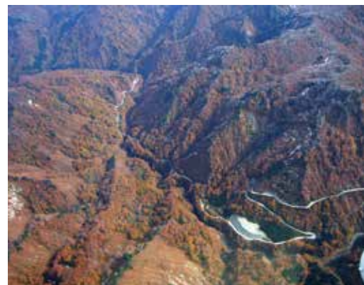
工事着手前 平成21年11月
