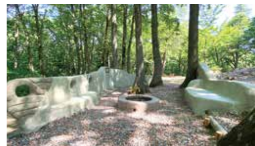
アースバッグ工法のスペース
