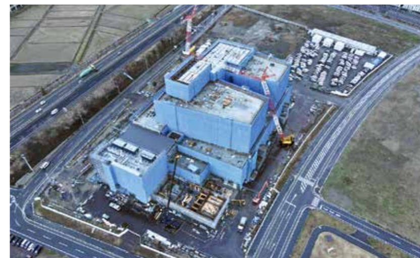
建設中の済生会新潟県央基幹病院
