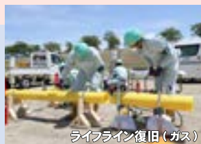
ライフライン復旧（ガス）
