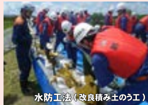
水防工法（改良積み土のう工）
