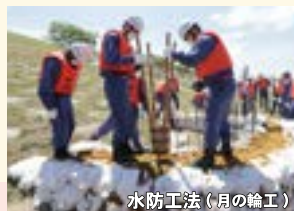
水防工法（月の輪工）
