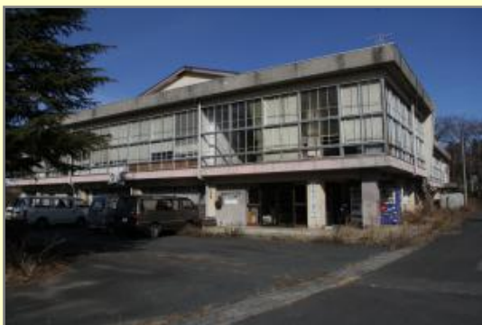
町民第一体育館
