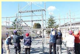
集会所前に足場を設置
