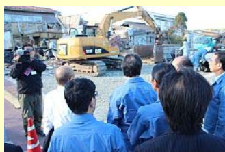
損壊家屋の取り壊し
