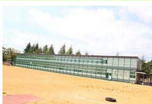
校庭西側に建てられた仮設校舎
