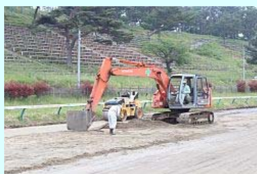
1周約1,000mの作業
