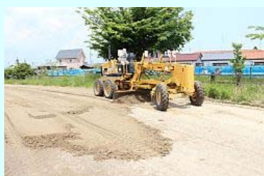
グレーダーで整地
