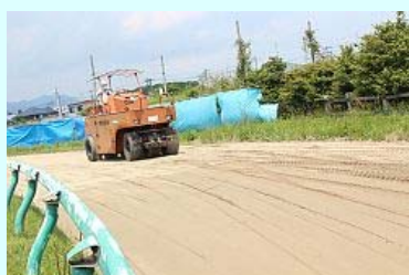
ローラーで締め固めます
