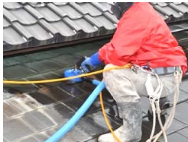
吸引式の高圧洗浄機での作業
