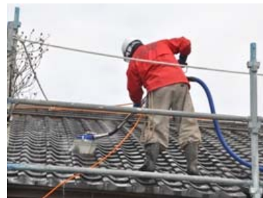
屋根瓦は別の機械での作業となります
