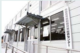
床面積513平方メートルの鉄筋平屋
