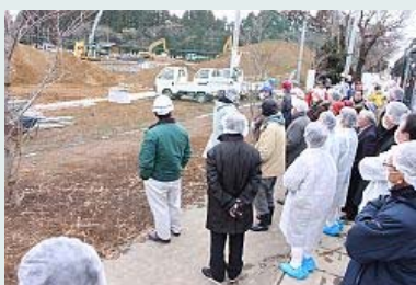
除染作業を見学
