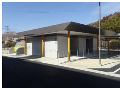
屋外の倉庫です。各住宅に倉庫が整備されています。
