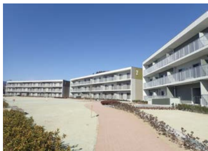
全ての工事が完了し、1～16棟まで全ての部屋が入居可能となりました。
