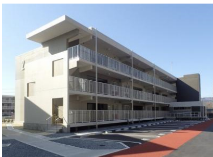
今回完成した2号棟を北側から見ています。住棟の北側に駐車場が整備されています。
