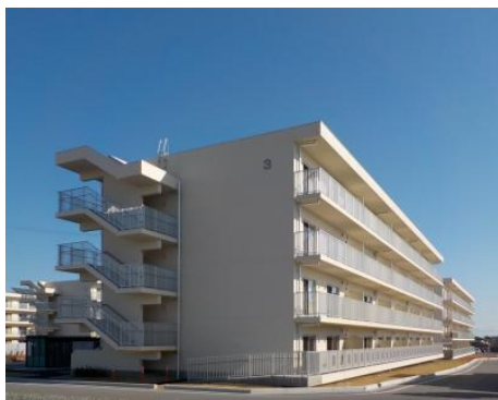
完成した3号棟
