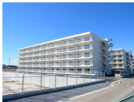
完成した4号棟
