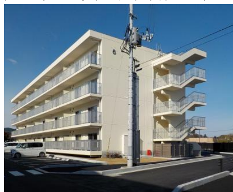
完成した6号棟
