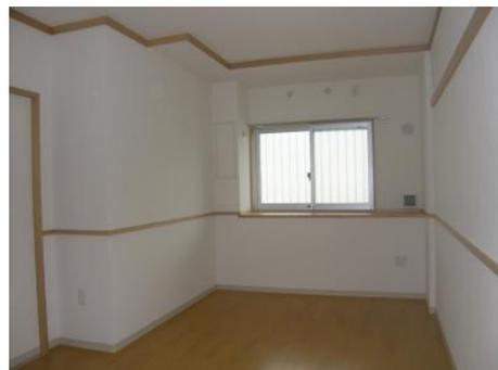
壁の中央に見切り材を入れることにより、ペットがクロスを破いた際、壁半分だけの部分的な貼り替えができるようにしました。
