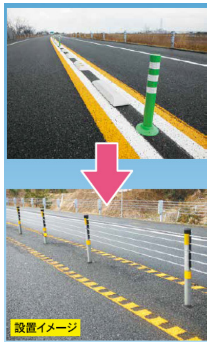
ワイヤロープ設置工事
