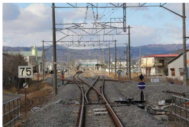
バラスト(砂利)が入れ換えられて きれいになった線路
