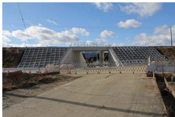
拡張される跨道橋（酒田）
