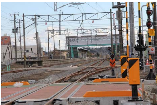
拡張される踏切（川添街道）
