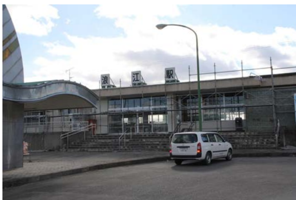
復旧作業のための足場が組まれた浪江駅舎
