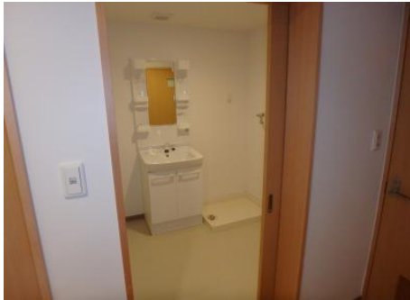
洗面化粧台、洗濯機パンを設置
