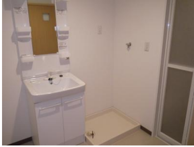
洗面化粧台、洗濯機パンを設置
