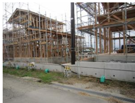
10月末現在、造成工事が完了しました。 現在は建築工事が着々と進められています。
