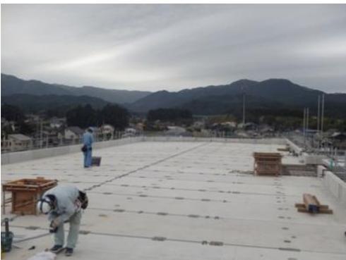
2号棟では、PCの建て込みが屋上まで完了しました。PC部材をジョイントするコンクリートを打設すると躯体工事が完了します。
