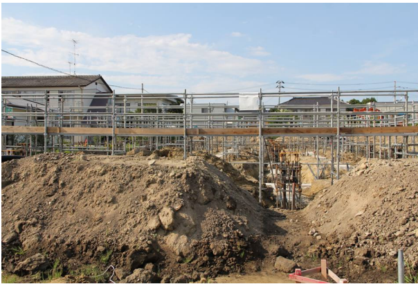
工事の様子(8月9日撮影)
