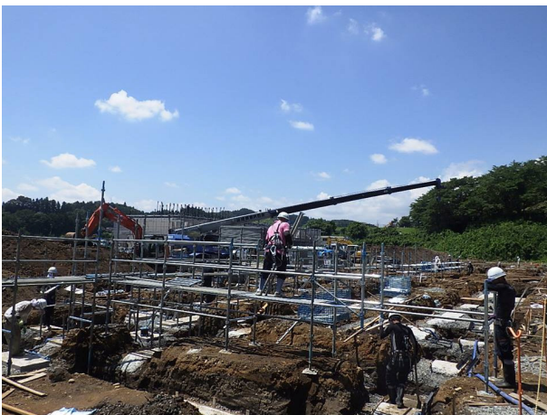
工事の様子(8月4日撮影)
