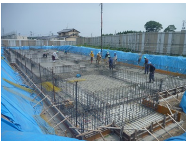
2号棟の基礎コンクリート打設状況
