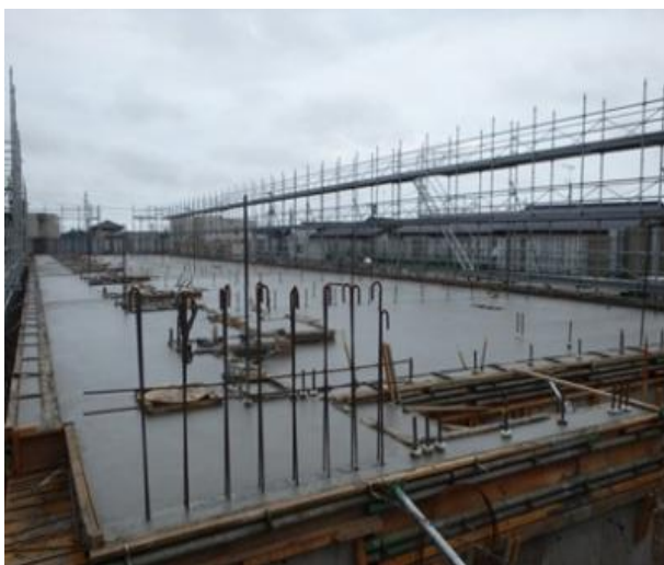
1号棟では、基礎工事が完了し、PCの建て方工事を開始します。
