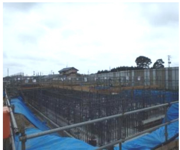
2号棟では、基礎地中梁の配筋や型枠の建て込みを施工しています。
