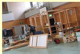
手際よく進む解体作業
