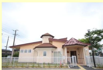
鹿島小学校南側に完成
