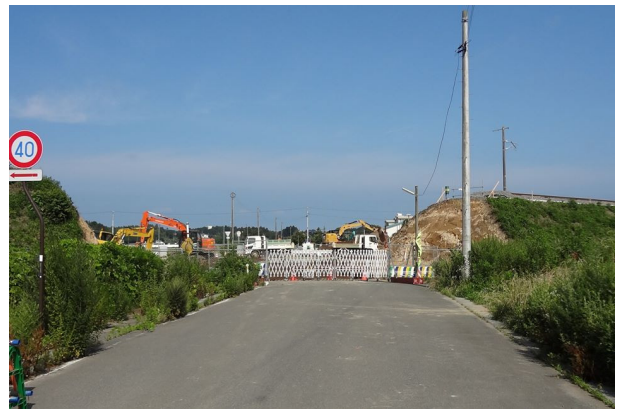
工事中の様子(7月12日撮影)
