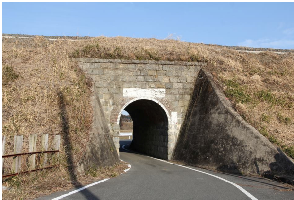
工事前の跨道橋
