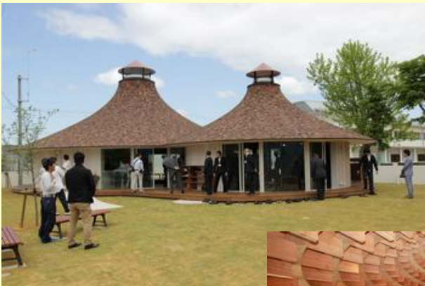
サーカス小屋をモチーフとした建物
