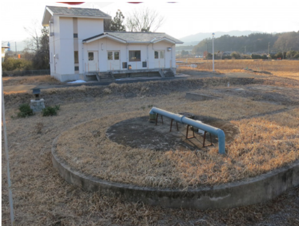
谷津田取水場（全景）
