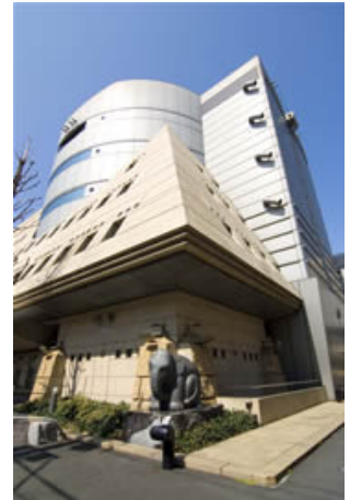
東京消防庁 本所都民防災教育センター (本所防災館)
