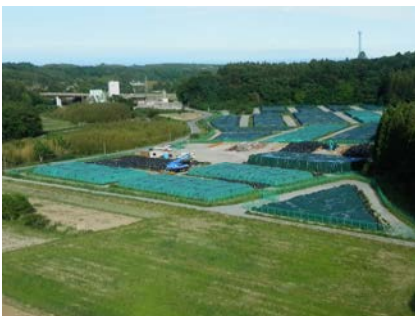
常磐道から見た仮置場
