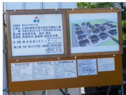
小高区東町災害公営住宅 建設工事現場
