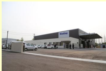
下太田工業用地に完成した工場
