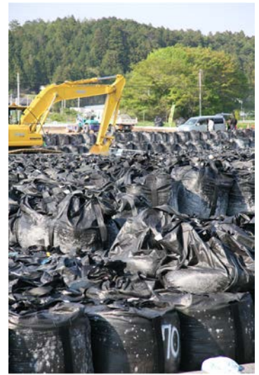
除染廃棄物が運び込まれる 仮置き場
