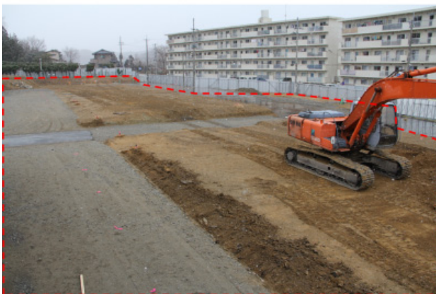
着工状況 平成26年2月4日(火)現在
