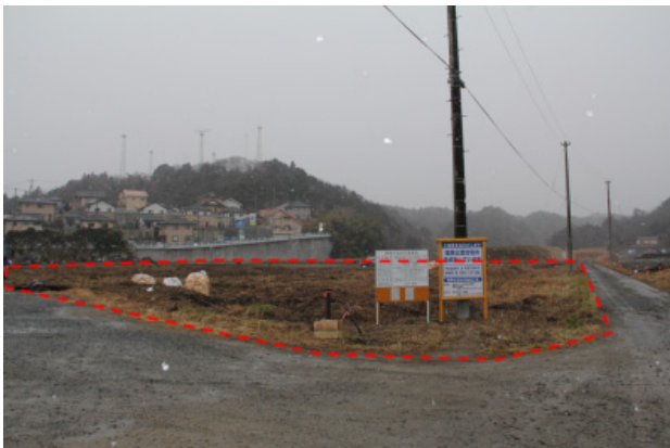
着工状況 平成26年2月4日(火)現在
